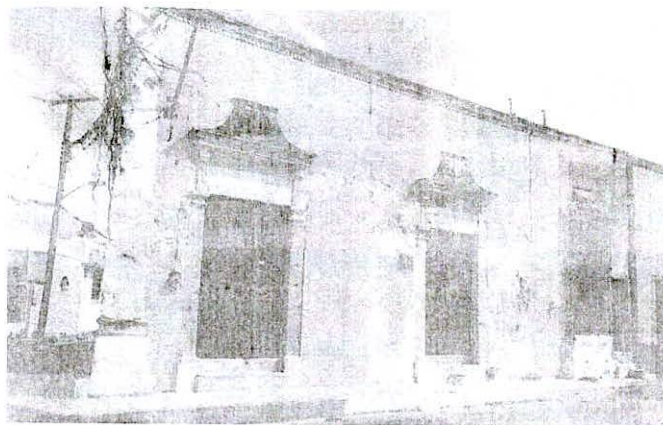
Inmueble con deterioros en la Calle 18
